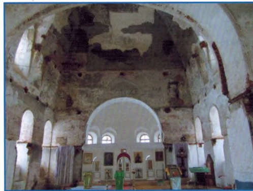
Пространство Зосимо-Савватиевского храма после демонтажа лагерных перекрытий. Фотография 2013 г.
