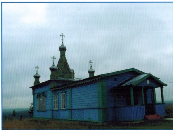
Вид часовни с северо-запада. Фотография 2013 г.
