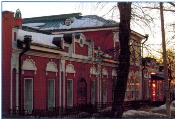
Парадный фасад здания. Фотография 2013 г
