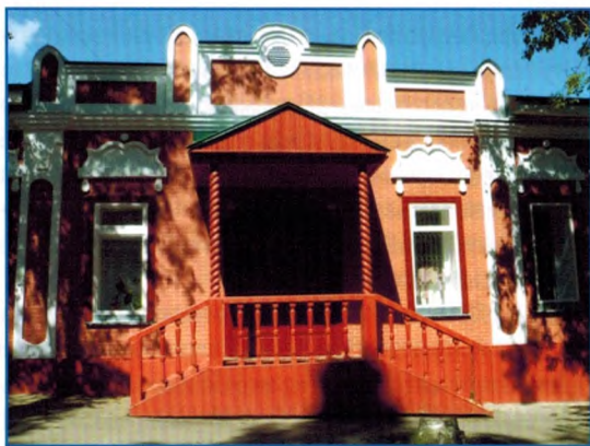
Деревянное крыльцо здания
