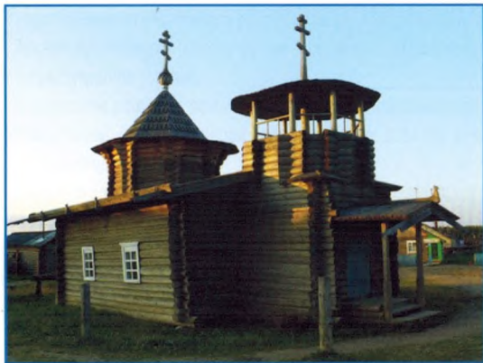
Общий вид памятника с северо-запада. Фотография 2010 г.
