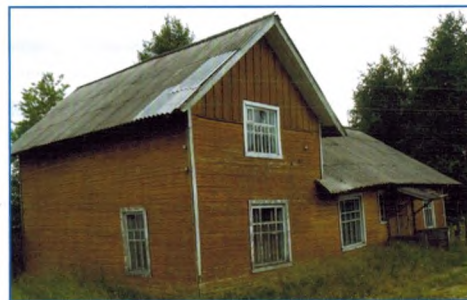
Штаб авиабазы. Вид с юго-востока. Фотография 2009 г.
